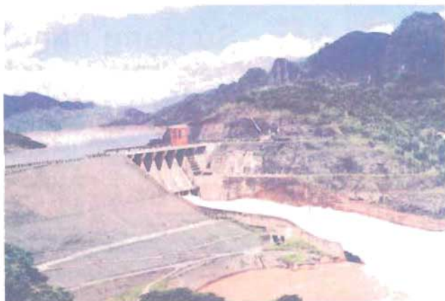
④ Nhà máy thủy điện
