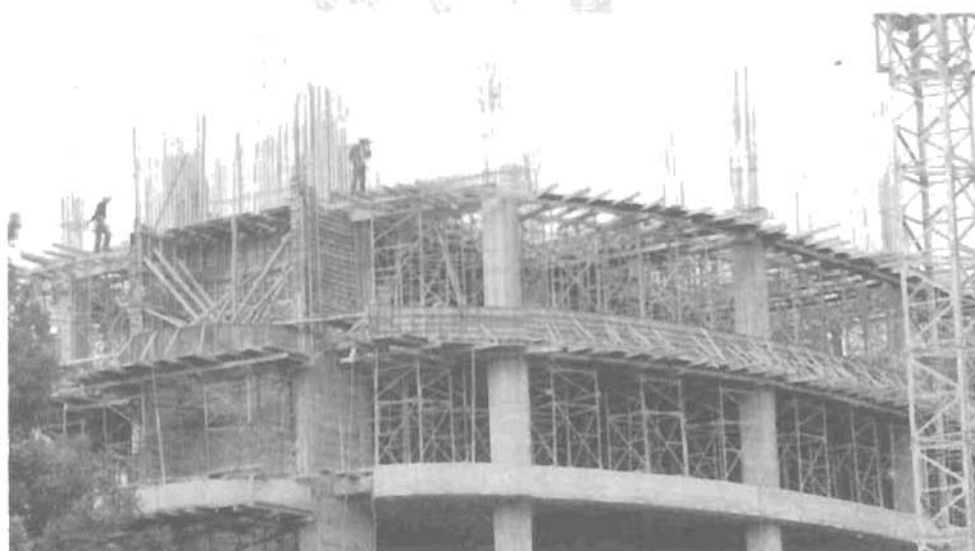
③ Đổ bê tông cốt thép
