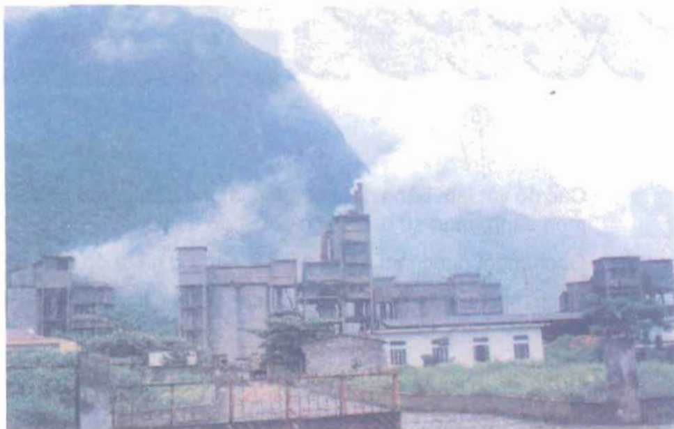
② Nhà máy xi măng Hà Giang
